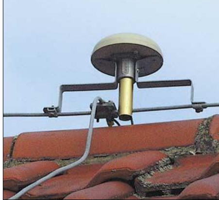
Bild 9: Ein exponierter Standort der GPS-Antenne sichert beständig ein optimales Referenzsignal. Die Montage erfolgte direkt am Blitzableiter auf dem Dachfirst. Fotos: DK6RX
